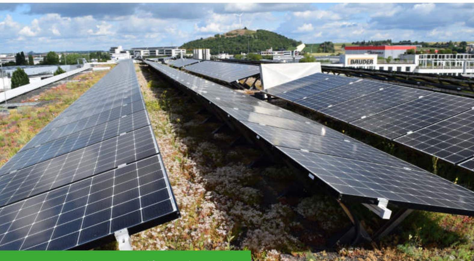
Abb. 15: Ein Beispiel für ein Solargründach mit Ost-West-Ausrichtung. Quelle: BuGG
