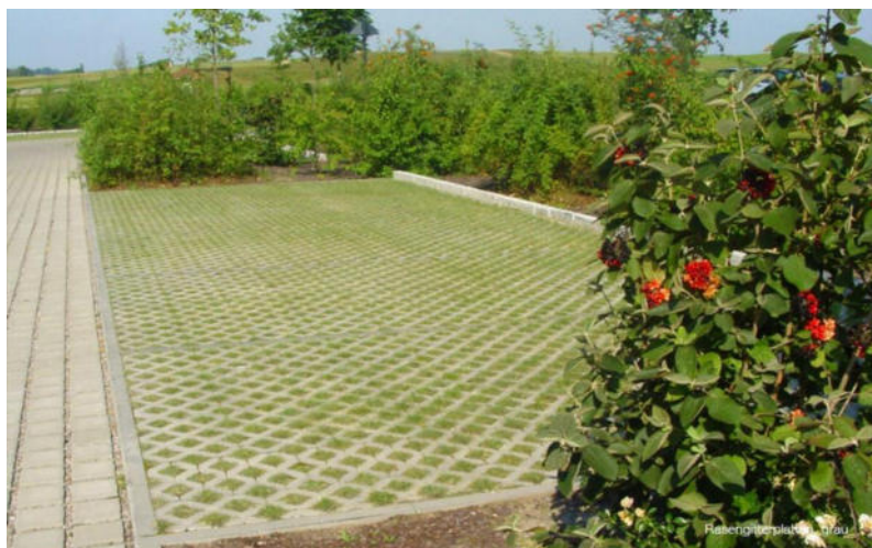
Entsiegelung von Verkehrsflächen
